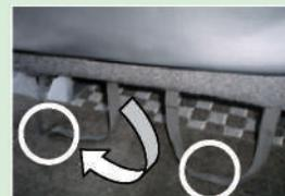
背面と座面とのフラップ(連結部分)は、座面下の隙間より手を差し込み、フックを外すか、ゴムを外して開けて下さい。
